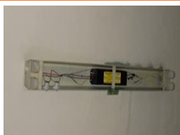
蛍光灯安定器
